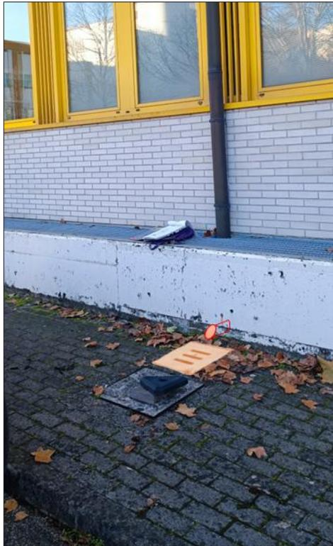
Figura 2 - Soluzione interferenze [ESA]. Intercettazione pluviale e scarico a terra su nuova caditoia posizionata sulla linea acque banche esistente.
